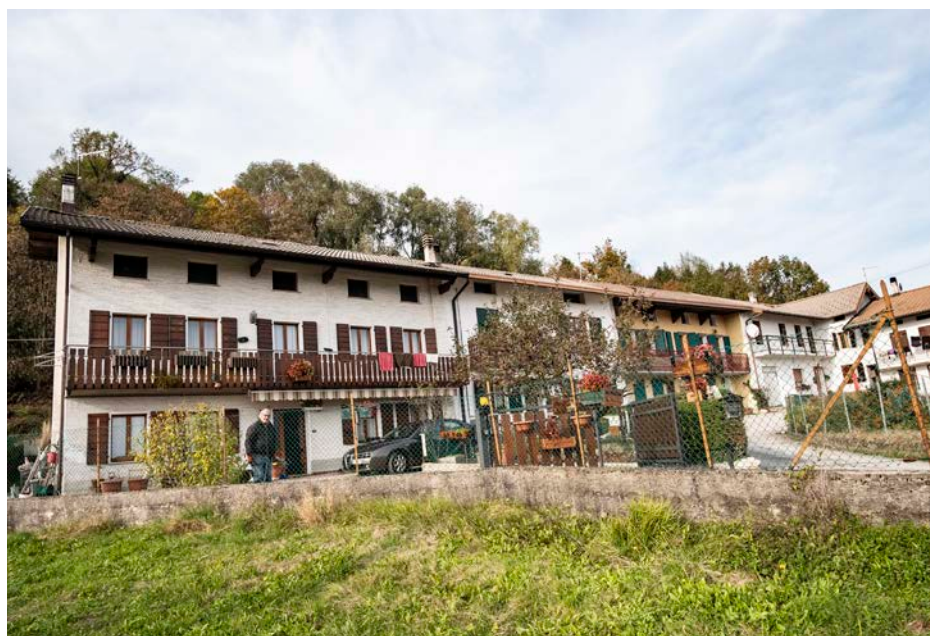
Località alle Mole, edificio che ospitava l'opificio idraulico (foto T. Meneguz)
