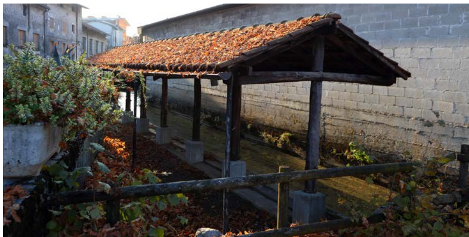
Antico lavatoio in via Molini, recentemente restaurato dal Gruppo Alpini di Maniago (foto F. Balzan)
