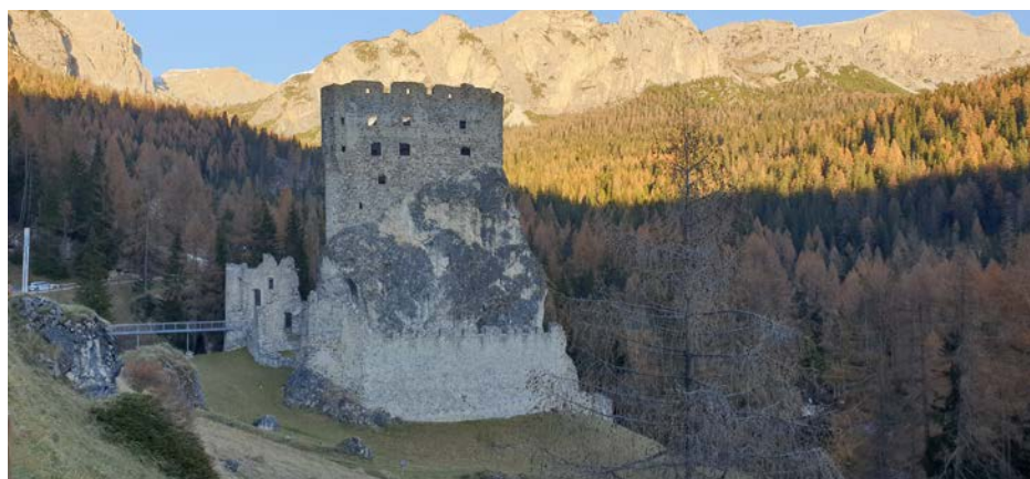
Veduta esterna del castello di Andraz (foto G. Tasser)
