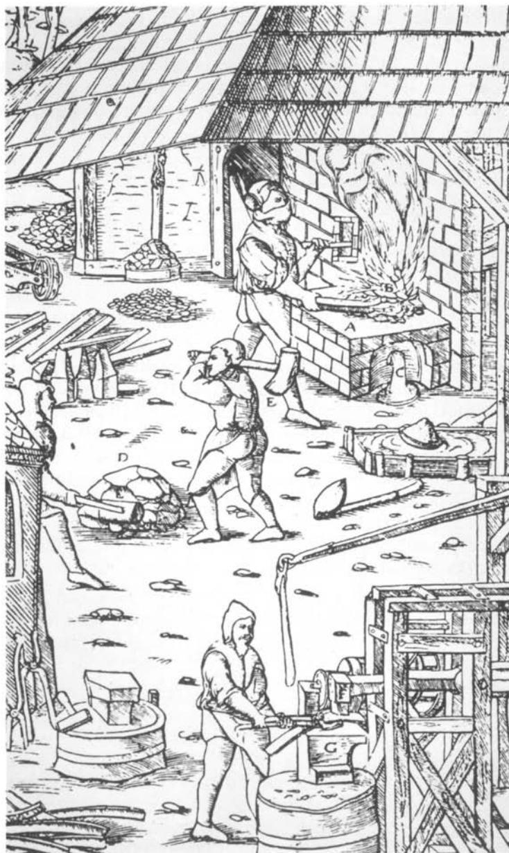
Le fusinelle, forgia, martinetto idraulico, pezzi di fusione e attrezzi di lavoro nel sec. XVI; da G. AGRICOLA, De re Metallica , (1556).
